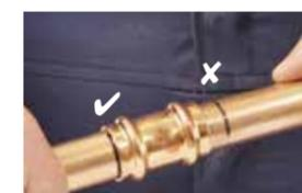
8. Insérez complètement le tube dans le raccord. Assurez-vous que le tube soit complètement inséré avant sertissage
