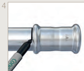
Marcar la profundidad de inserción
