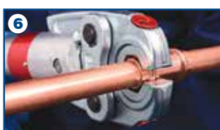
6 Allineamento delle ganasce al raccordo
