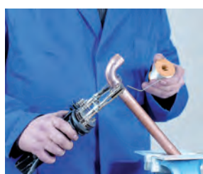
5- Appliquer la soudure
