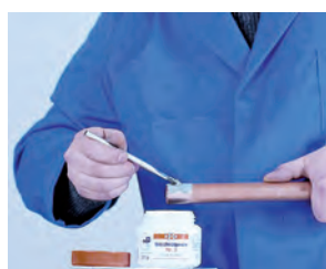
4- Appliquer le décapant
