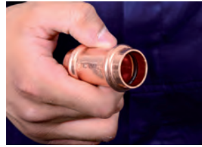
3. Vérification du joint torique
