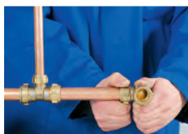
3. Insérer le tube dans le raccord
