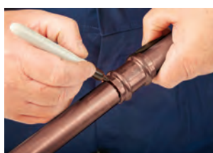
4. Assemblage et marquage de la profondeur d'insertion
