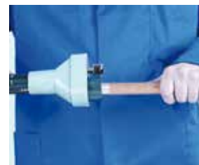
3. Limpieza exterior del tubo 3. Limpeza exterior do tubo
