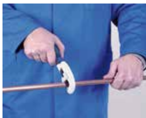
1. Corte de tubo 1. Cortar o tubo
