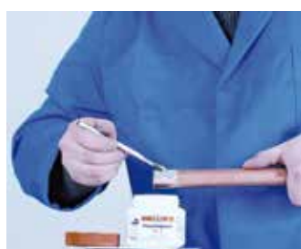
4. Aplicación del decapante 4. Aplicação do decapante
