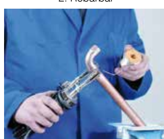
5. Aplicación de la soldadura 5. Aplicação da soldadura
