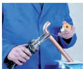
5. Aplicación de la soldadura 5. Aplicação da soldadura
