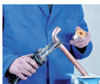
5. Aplicación de la soldadura 5. Aplicação da soldadura
