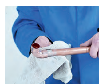
6. Limpieza final 6. Limpeza final
